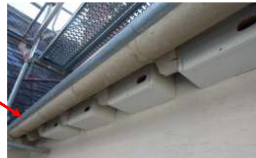
Hier 4x Holzkasten mit 60° Dachneigung wettergeschützt unter dem Dachüberstand.
